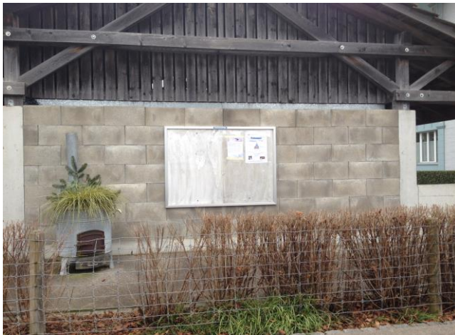
Nebengebäude Schulhaus Schoren (Seite Hodelgasse)
