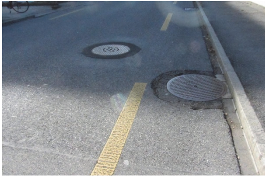
Schorenstrasse: Einlaufschächte auf dem schmalen Velostreifen
