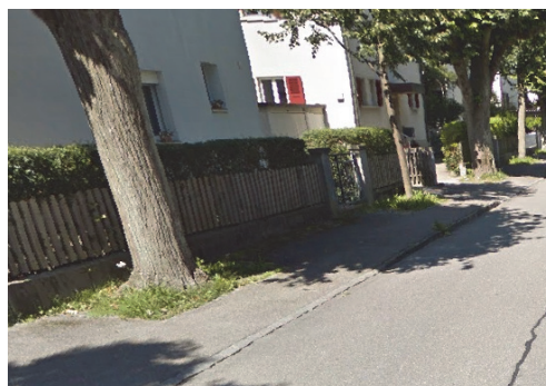
Trottoir ist durch Baumscheiben beeinträchtigt
