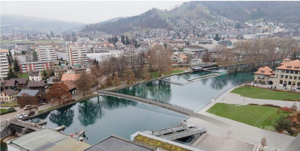
Visualisierung 4-Felder Brücke mit Durchlaufträger
