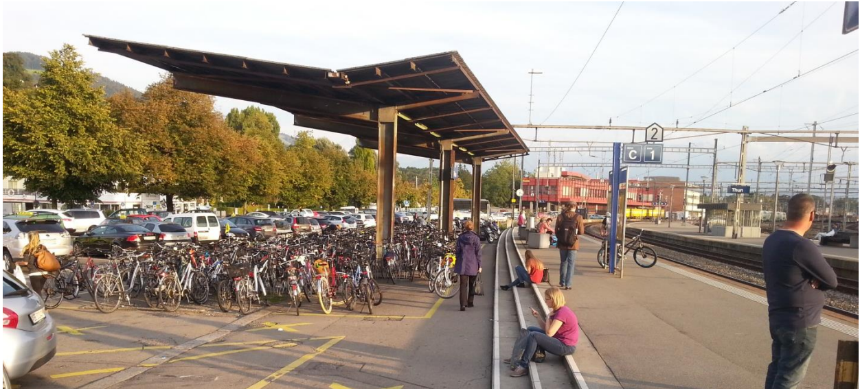
Die bestehende Veloabstellanlage Stückgut Süd befindet sich unmittelbar bei Gleis 1 und ist meist überfüllt (Foto: P/N)
