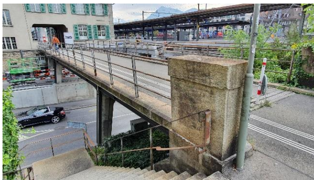
Bild 1: Bestehende Passerelle Frutigenstrasse
