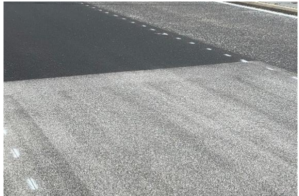
Abbildung 6: Nach dem Abschleifen eines SDA 4 Belags (ungeschliffen vs. geschliffen).
