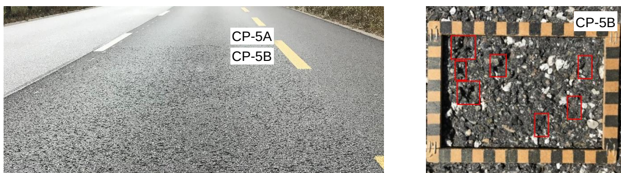
Abbildung 13: Links: Aufnahme der SMA 8 Beläge CP-5A (2-5 mm Abstreu) und CP-5B (5-8 mm Abstreu). Rechts: Nahaufnahme des CP-5B. Auf der linken Aufnahme sind die Kornausbrüche (Löcher) des gröberen Abstreus deutlich sichtbar im Vergleich zu den feiner abgestreuten Körnern des CP-5A. Die einzelnen Kornausbrüche sind in der Nahaufnahme rot umrandet.
