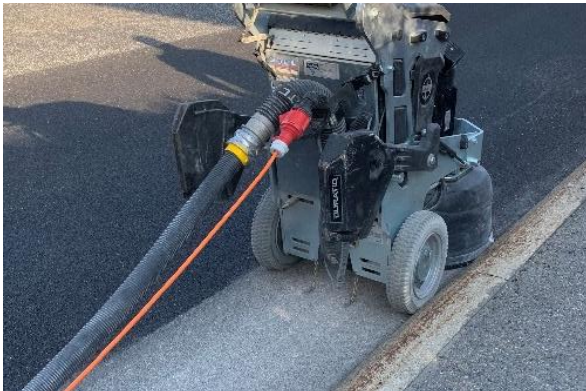
Abbildung 5: Abschleifen eines SDA 4 Belags mit einer Schleifmaschine.
