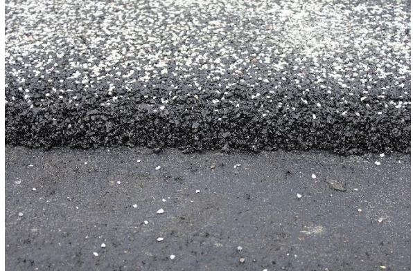
Abbildung 4: Nahaufnahme des eingewalzten hellen Splitts.
