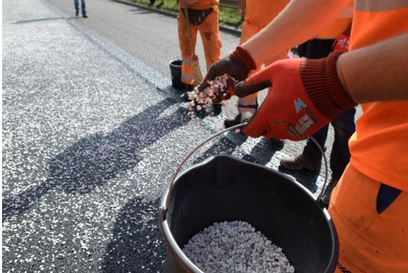
Abbildung 3: Belagseinbau mit Abstreuen von hellem Splitt.
