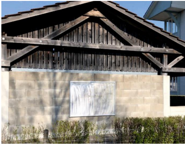
Nebengebäude Schulhaus Schoren (Seite Hodelgasse)
