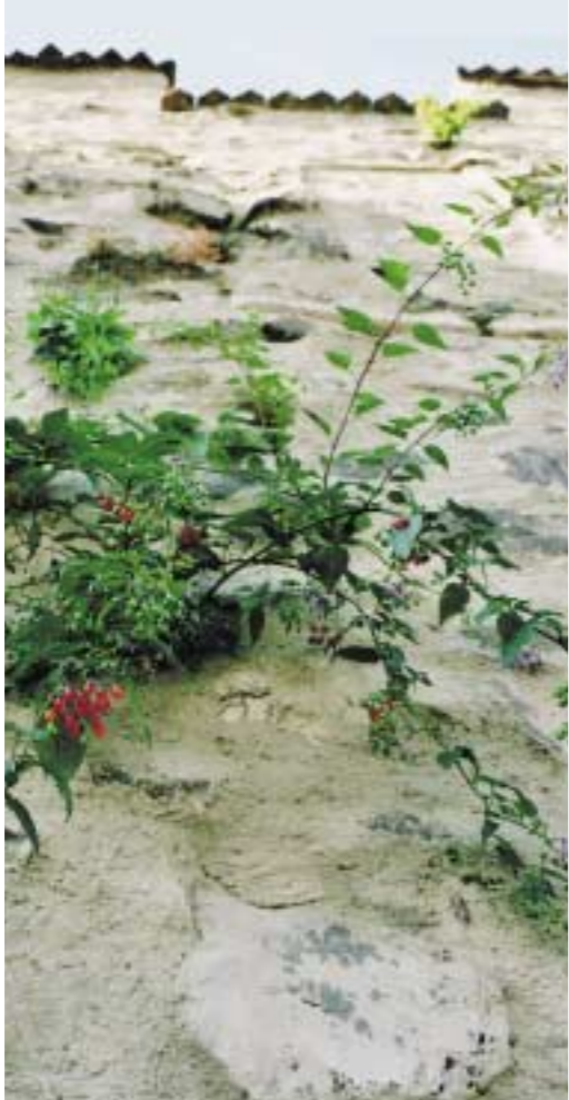
Pflanzenvielfalt an der sanierten Mauer
