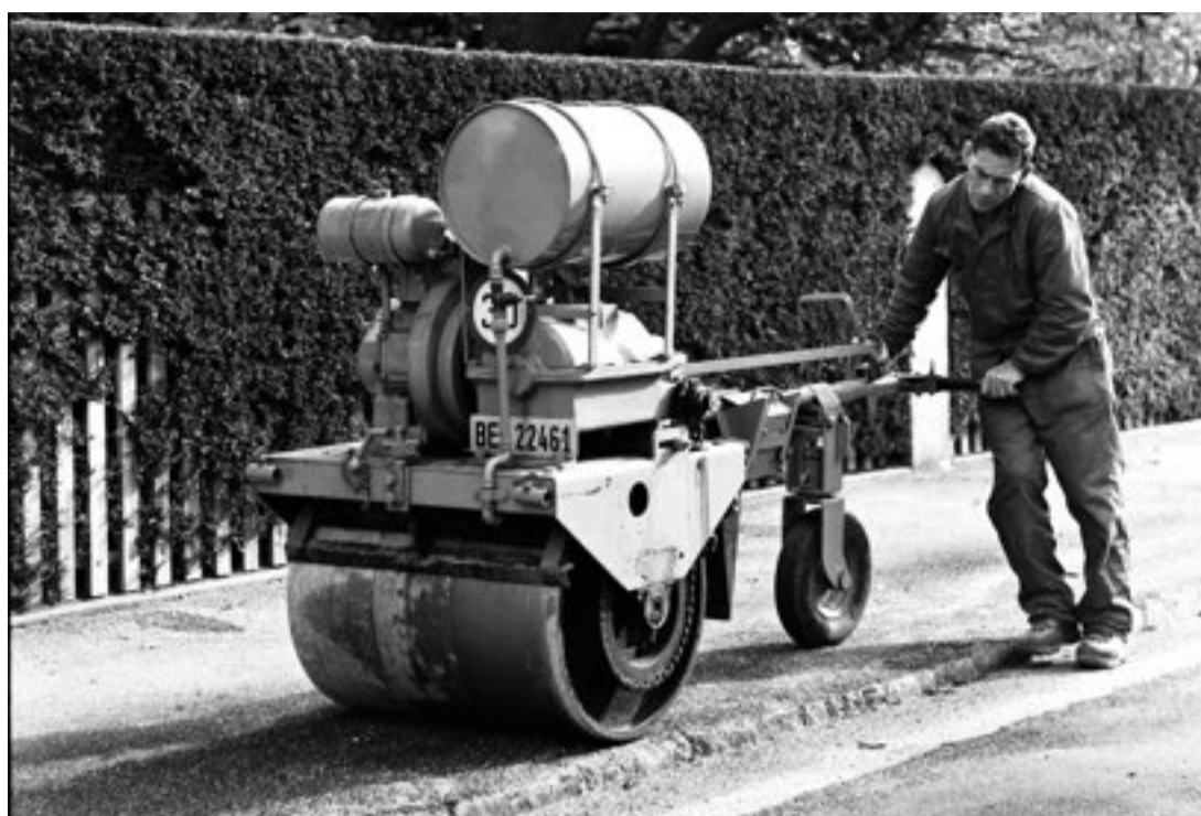
Belagsarbeiten im Jahr 1966 in Thun: Damals wurden die Arbeiten noch von Hand ausgeführt.
