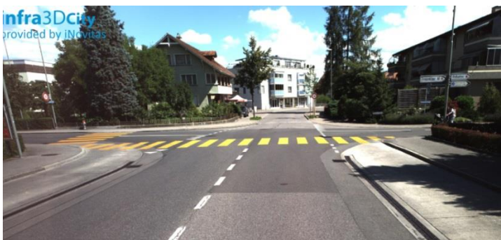
Bsp. Lerchenfeldstrasse, Überbreite Fahrbahn
