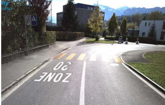
Bsp. Stationsstrasse, ungenügende/fehlende Beleuchtung
