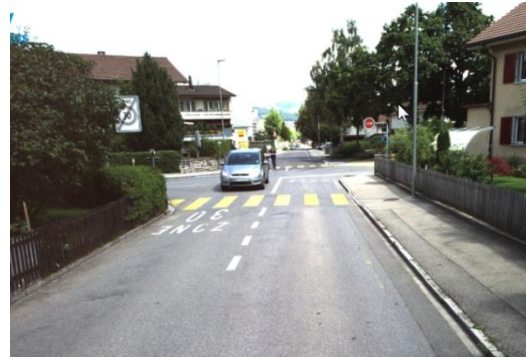
Bsp. Mattenstrasse, Bepflanzung behindert Sichtverhältnisse
