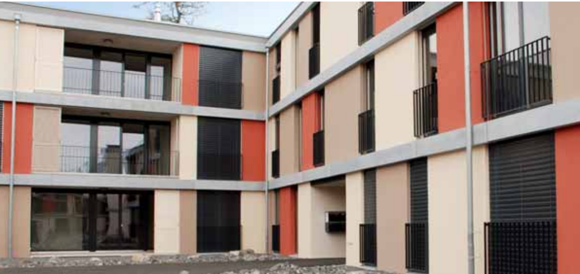
Dreigeschossige, moderne Mehrfamilienhäuser stehen heute anstelle der früheren einfachen Wohnungen aus den 1940er-Jahren.
