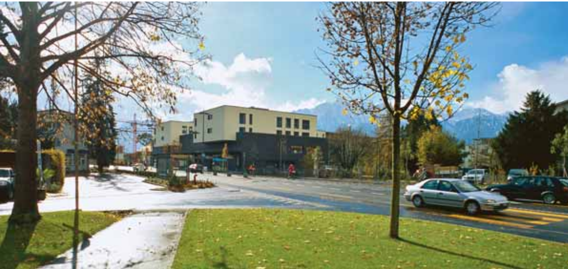
Der Hohmadpark liegt an attraktiver und zentraler Südwestlage in der Mehrgenerationensiedlung Hohmadpark in Thun.
