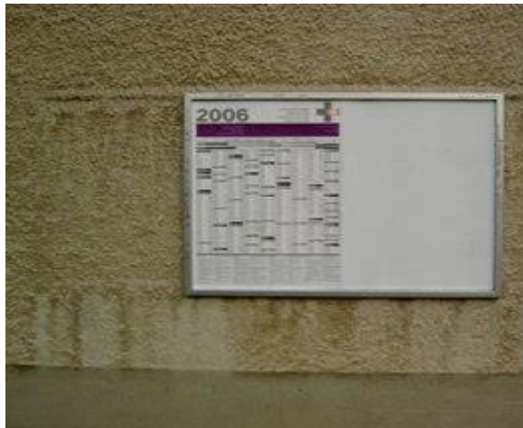
Tellstrasse (Schulhaus Hohmad)
